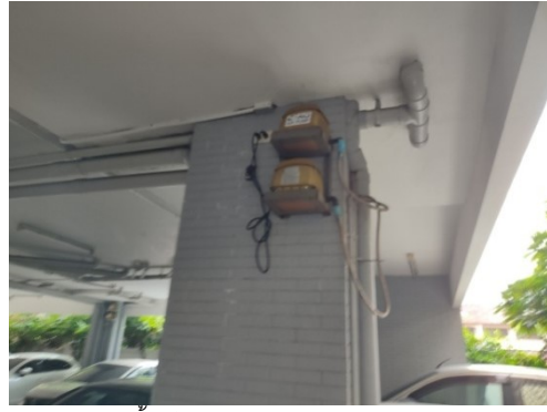
ภาพที่ 4-3 บั้มเดิมอากาศในระบบบำบัดน้ำเสียแต่ละส่วน
